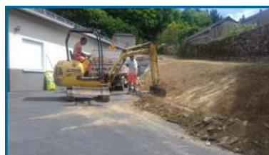
Réfection du mur en pierre sur la route de Biot à la Causade
