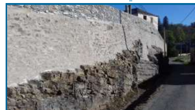
Aménagement de la zone poubelles à Cugnasse
