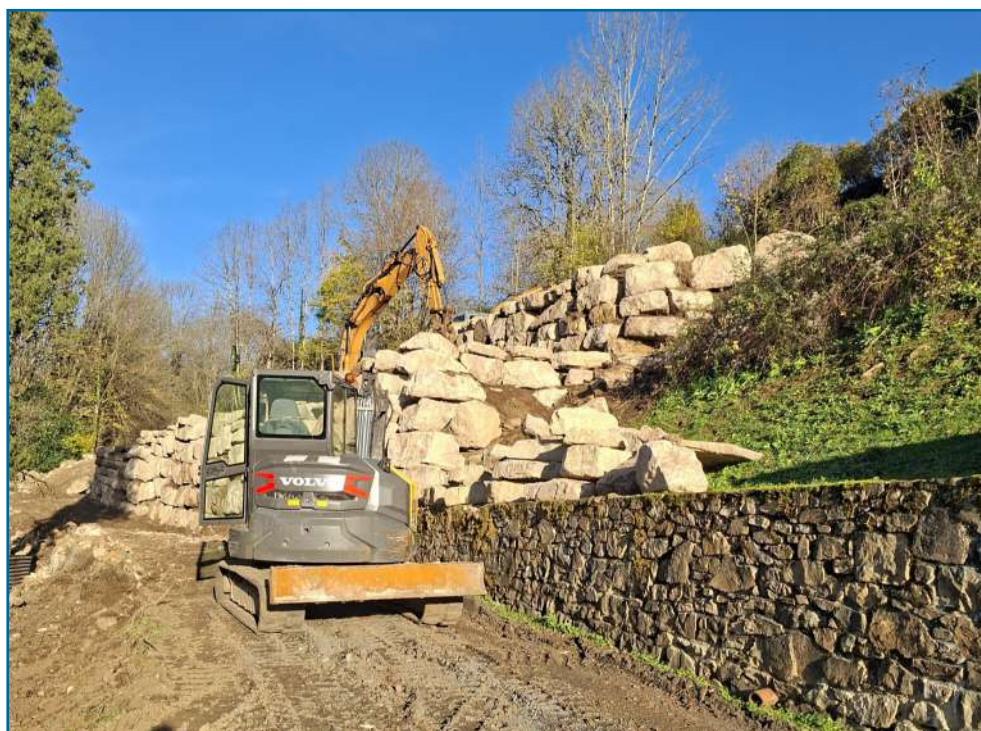
Travaux d'agrandissement du cimetière communal de Ferrières réalisés par l'entreprise Solaco
