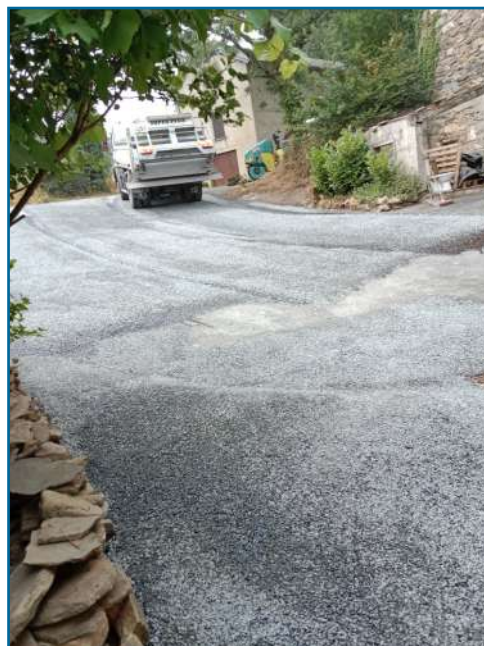
Rénovation de la place du Teil-Bas en juillet 2025
