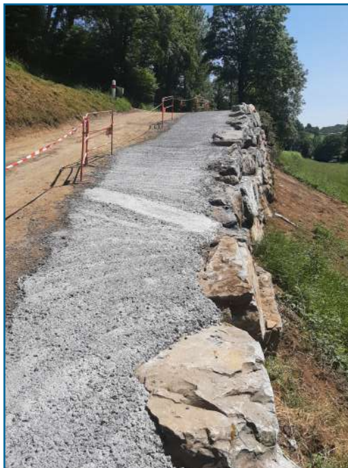
Au carrefour de Longuevergne enrochement de soutènement réalisé par l'entreprise CNTP
