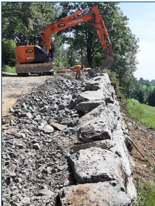
Au carrefour de Longuevergne enrochement de soutènement réalisé par l'entreprise CNTP
