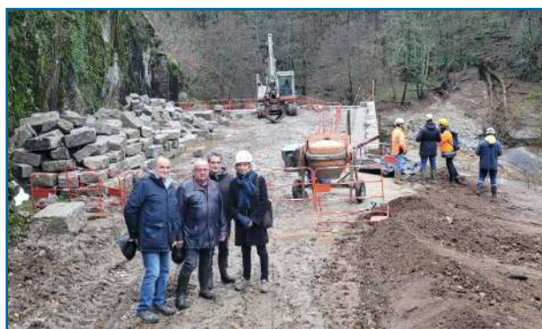
Chantier d'aménagement de l'aire de pique-nique
