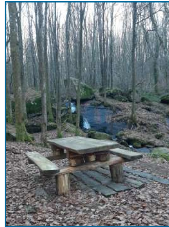
Réalisation d'une aire de pique-nique en forêt de Montagnol à côté d'une cascade
