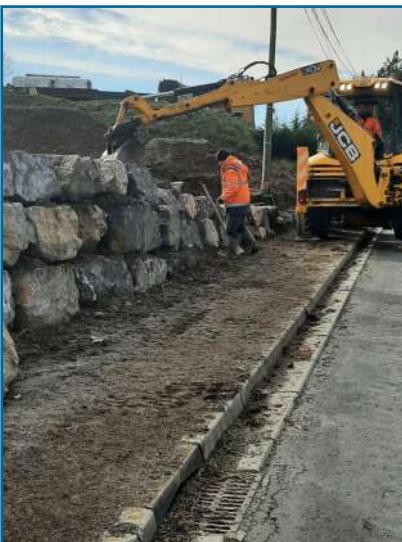
Réalisation d'un mur en enrochement à la nouvelle Mairie, le long de la route départementale, par les employés de la commune
