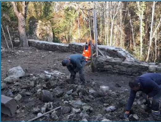
Réalisation d'un mur en enrochement à la nouvelle Mairie, le long de la route départementale, par les employés de la commune
