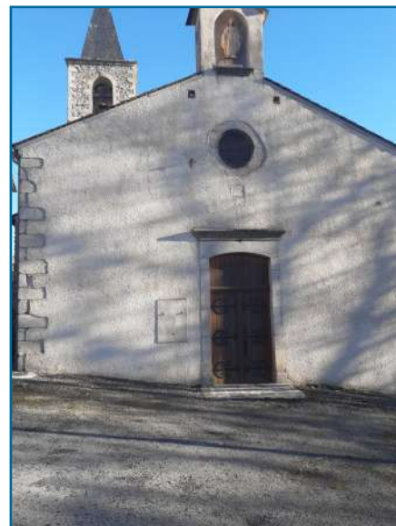
Drainage et reprise du parvis de l'église de Jaladieu
