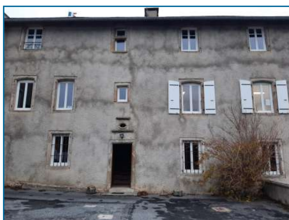
Réhabilitation de la mairie en MAM, salles de réunions pour les associations et appartement
