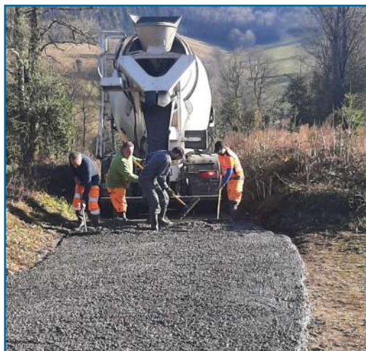
Bétonnage du chemin qui monte au captage d'eau de Merquier
