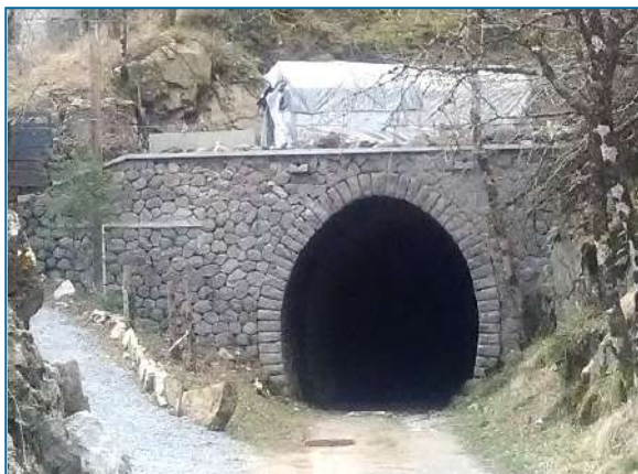
Travaux effectués sur la face avant du tunnel de l'ancienne ligne du Petit Train à Ferrières
