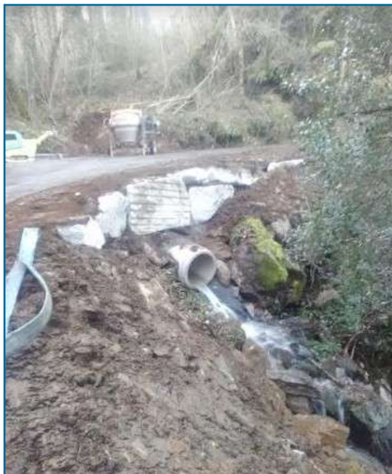
Réparation de l'aqueduc entre La Pause et La Canipèze endommagé par les fortes pluies
