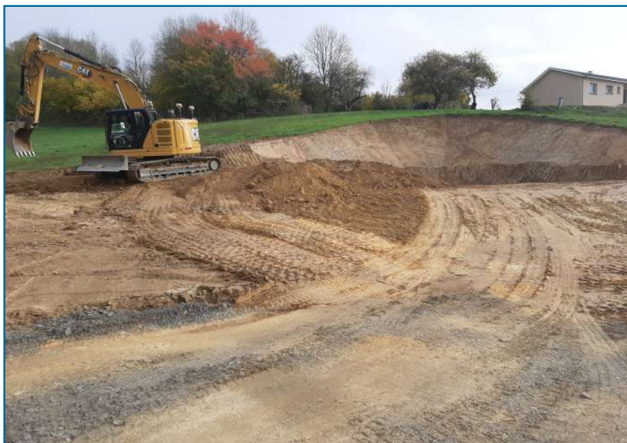
Terrassement pour la construction du nouvel ensemble Mairie - Service technique
