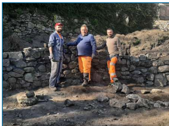
Reprise d'un mur au Mas de Prades-Bas
