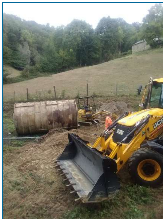
Remise en état de la station d'épuration de la Métairie Haute
